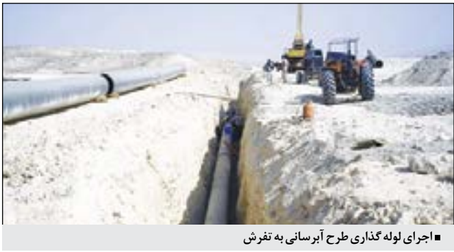
اجرای لوله گذاری طرح آبرسانی به تفرش
