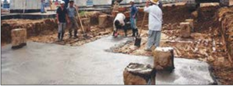
نمایی از ساخت پروژه پتروشیمی فیروزآباد با ۱۲ درصد پیشرفت
